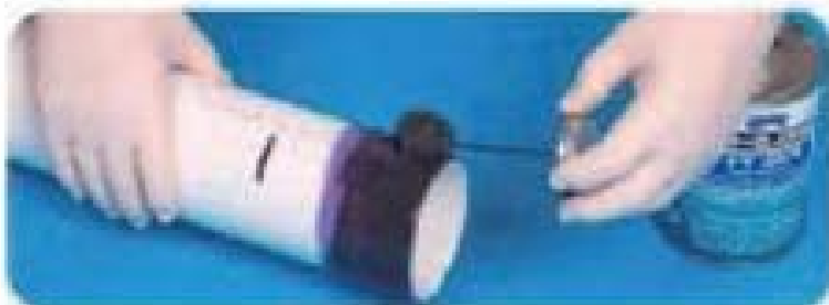
10. 胶粘剂再次涂抹管道
