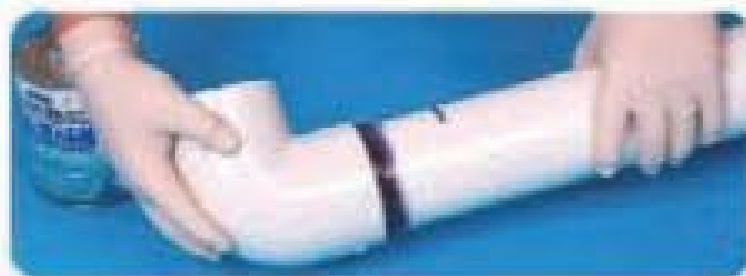
11. 边推至底部边旋转1/4圈，按住30秒防止反弹
