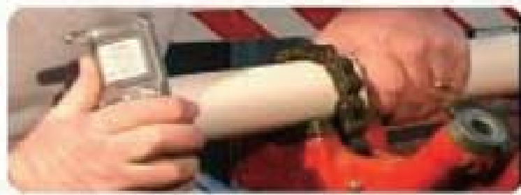
2. 管道倒角10-15°，清理边角碎屑
