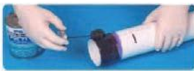
8. 胶粘剂涂抹管道
